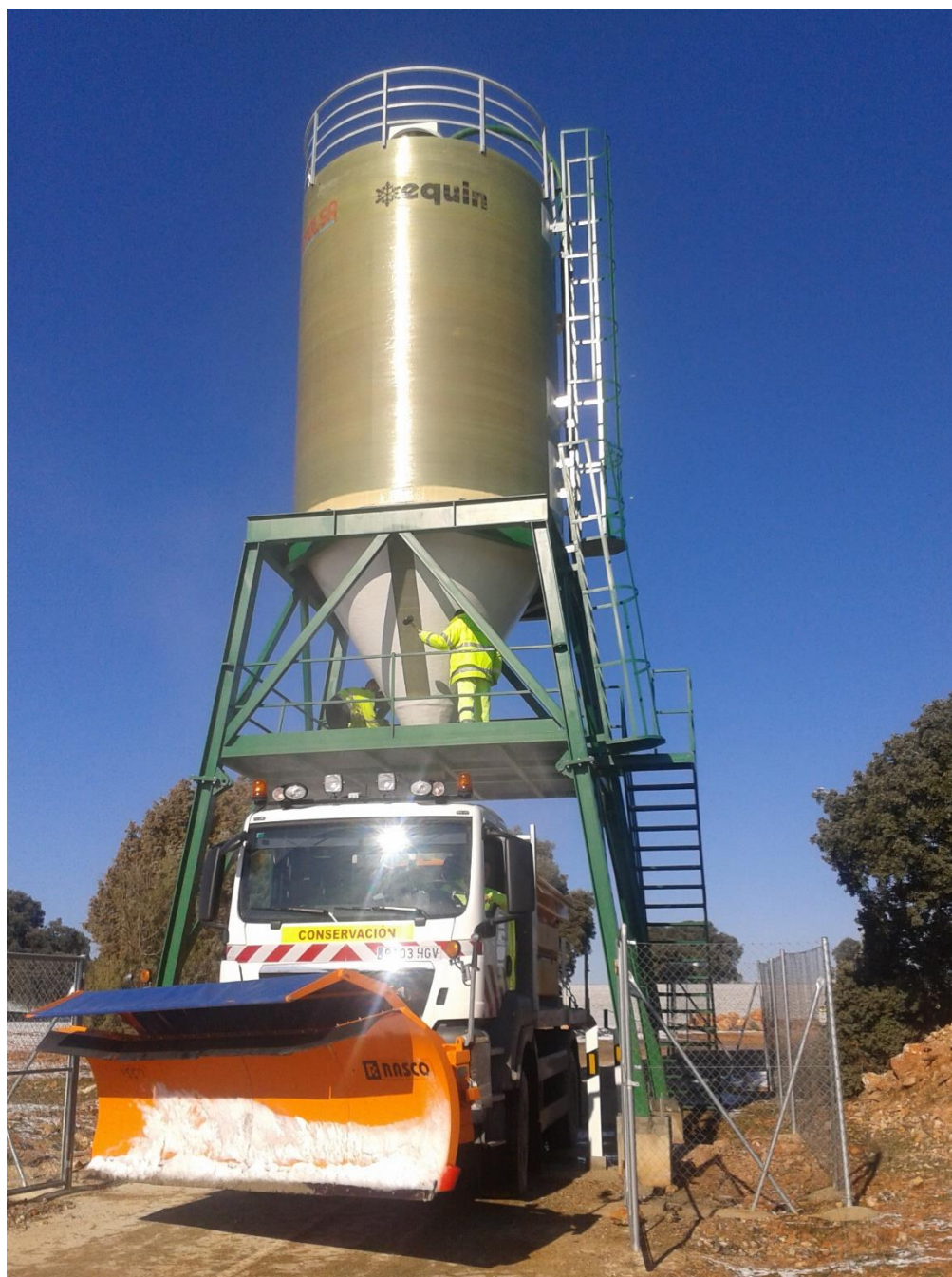
Silo. N-430 p.k. 421+110, margen derecha
