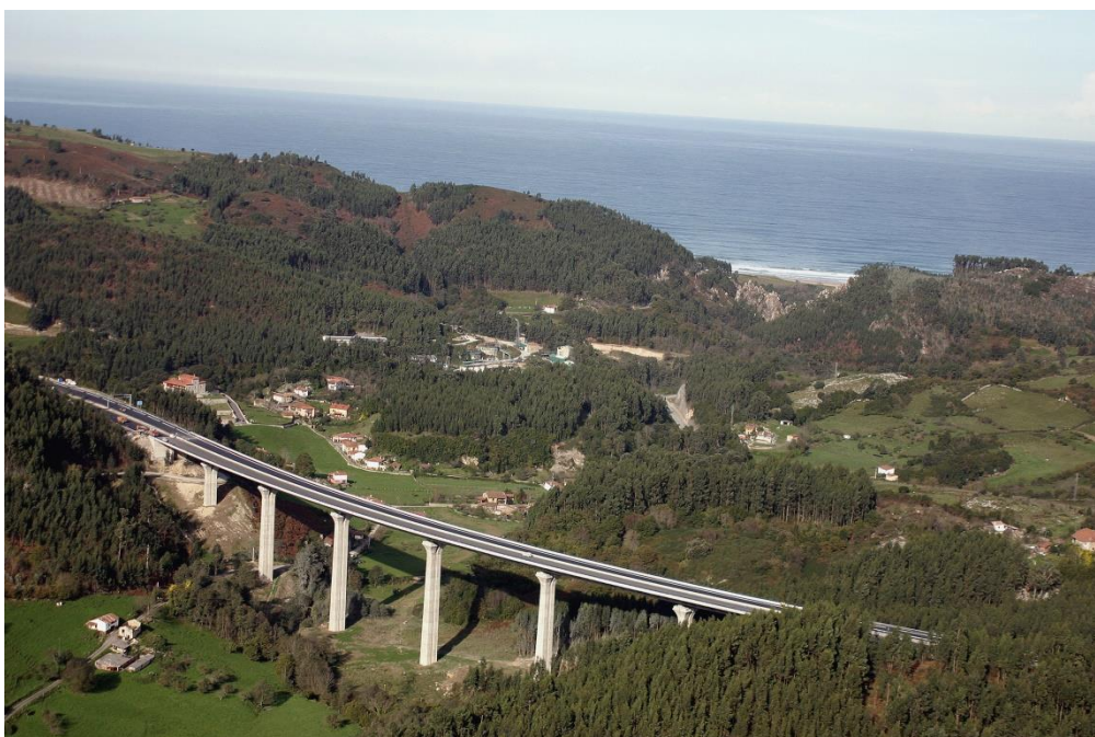
Viaducto del Acebo en el km 326,500 de la autovía A-8 (466 metros de longitud).
