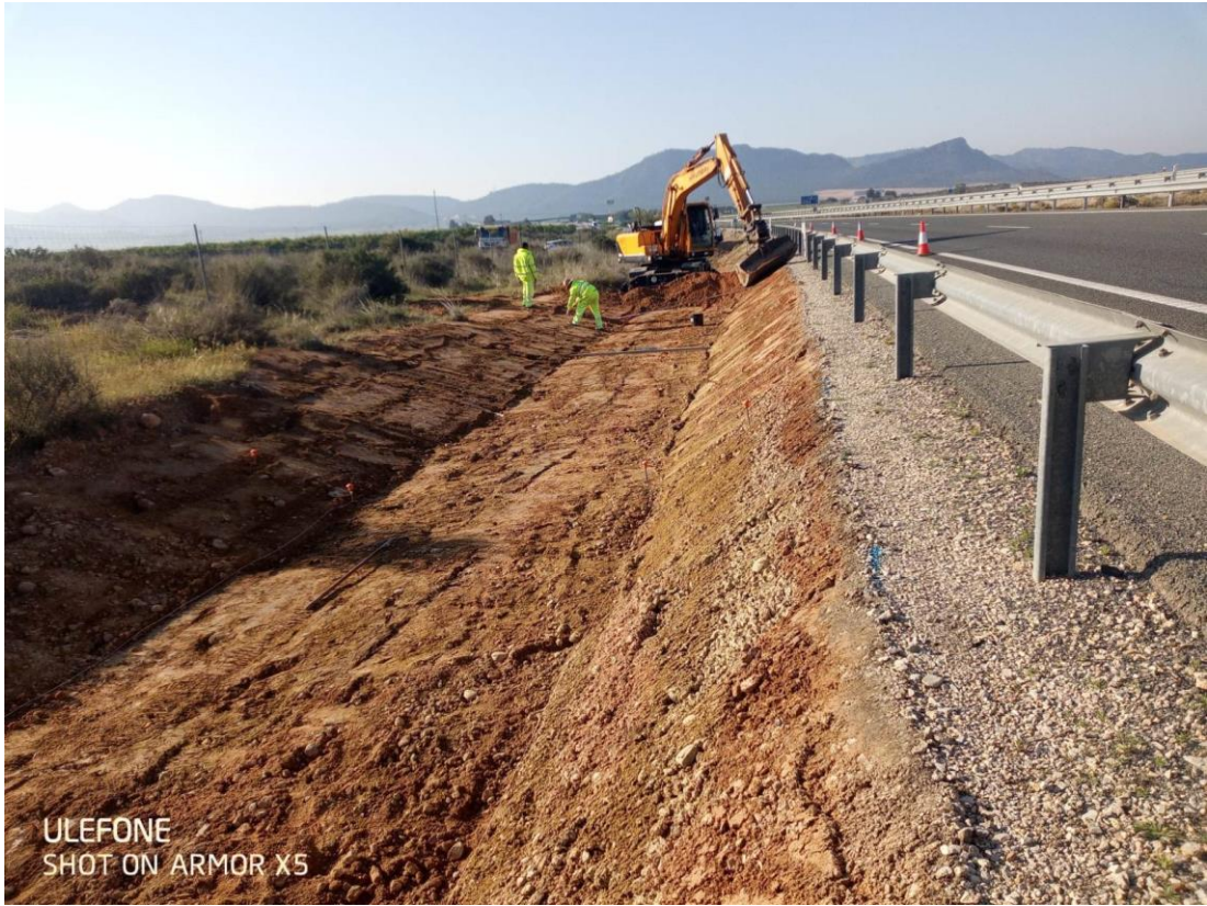
Revestimiento cunetas. A-30 p.k. 68+700 calzada izquierda (exterior)
