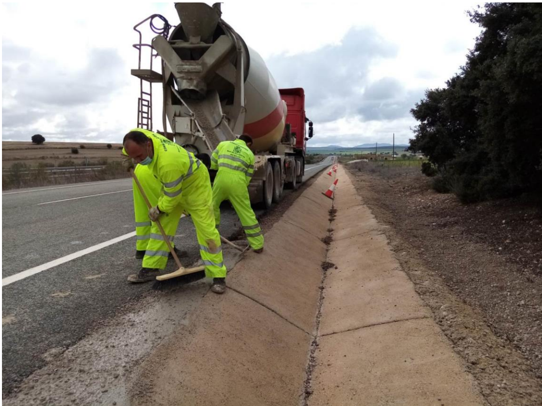
Revestimiento cunetas. N-301 p.k. 266+000, margen derecha
