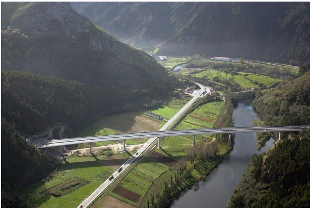
Viaducto del Sella en el km 320,250 de la autovía A-8 (542 metros de longitud)
